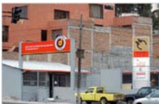
Distribuidora San Eduardo - Quito
